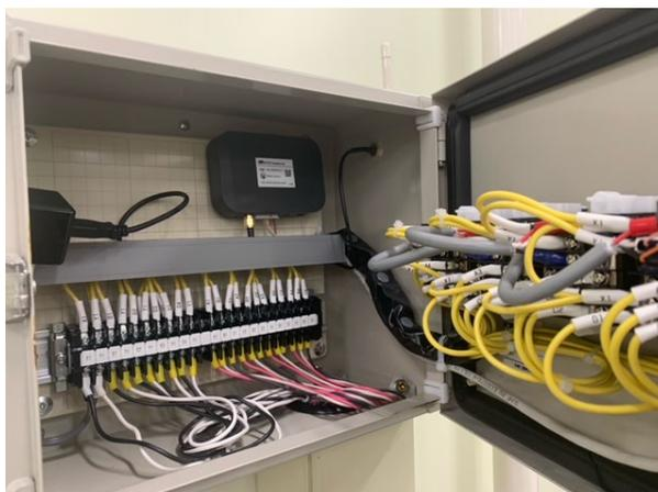
ひとつの変換ユニットに各社の温調器を接続。最大 4 台まで接続可能(マルチドロップ接続)。
